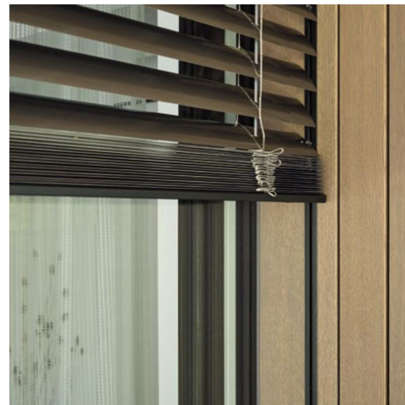
Raffstore mit in die Holzverkleidung eingelassener/eingeputzter verdeckter Führungsschiene.
